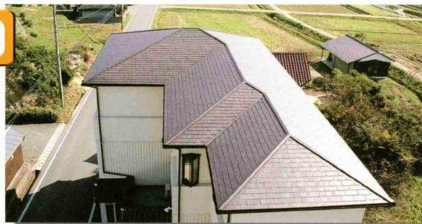
●施工後/カラーステンレス艶消しブラウン使用
