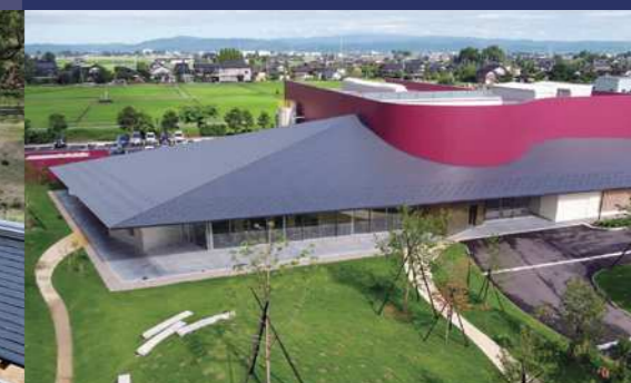
■株式会社能作 新社屋・工場(カラーGL鋼板) ●設計/アーキヴィジョン広谷スタジオ ●施工/塩谷建設株式会社
