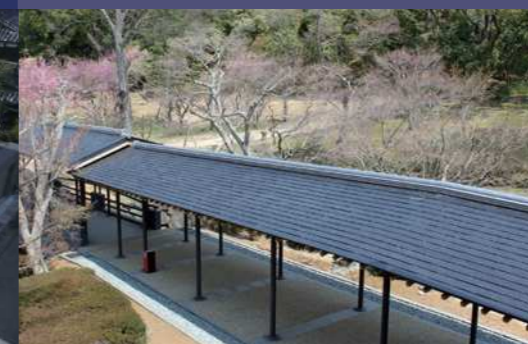
■新公会堂〜シルクロード交流館渡り廊下(硫化銅板) ●設計/(株)礎建築事務所 ●監理/(有)森馬都市創造設計 ●施工/(株)尾田組
