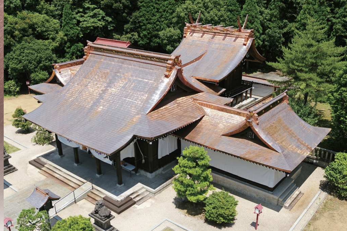
■橘神社(長崎県雲仙市) 材質:銅板 ●施工/(株)屋根工房
