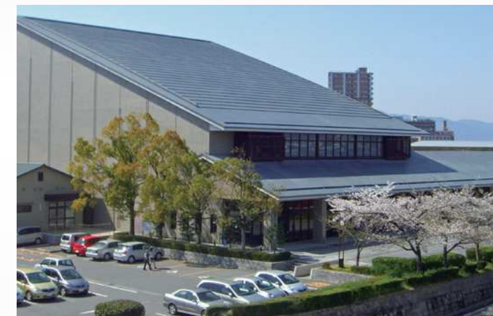
■県立草津文化芸術会館(滋賀県草津市) 材質:緑青銅板(現在は生産中止) ●設計/滋賀県建築設計管理事業協同組合 ●施工/(株)笹川組
