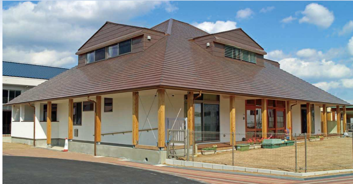
■舞多間よつば保育園 材質:銅板 ●設計・監理/伊藤設計室 ●施工:株式会社/平尾工務店
