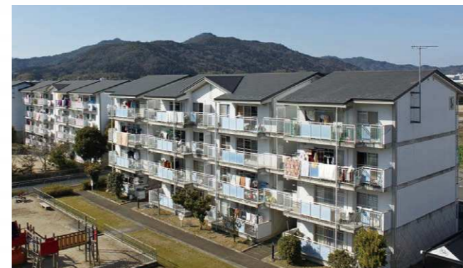
■京都府営穴川団地 材質:遮熱銅板ギングロ ●設計/京都府南丹土木事務所 ●施工/株三煌産業(株)共立工務店
