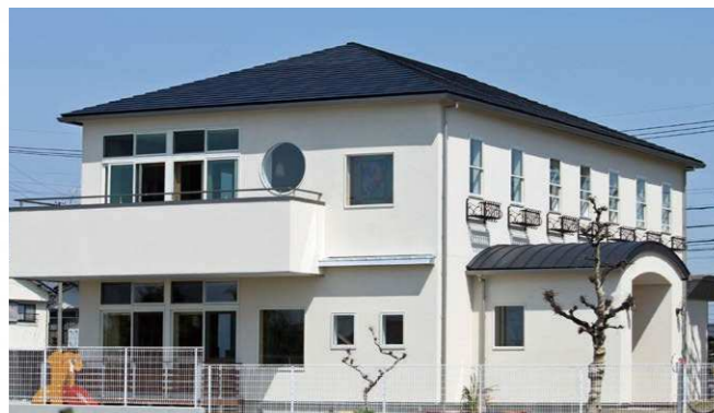
■子どもの庭保育園 材質:硫化銅板 ●設計/三輪田建築事務所 ●施工/中電不動産株式会社
