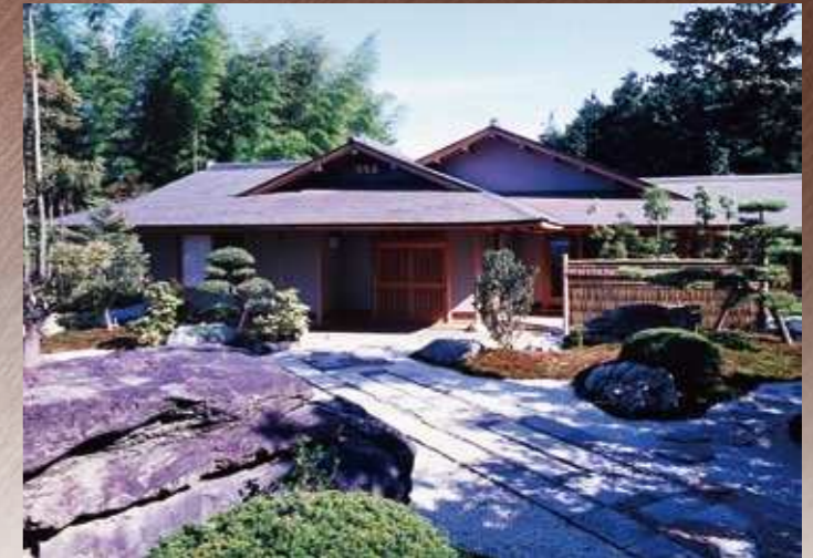
■伊勢の郷(三重県伊勢市) 材質:銅板 ●設計・施工/(株)新井組
