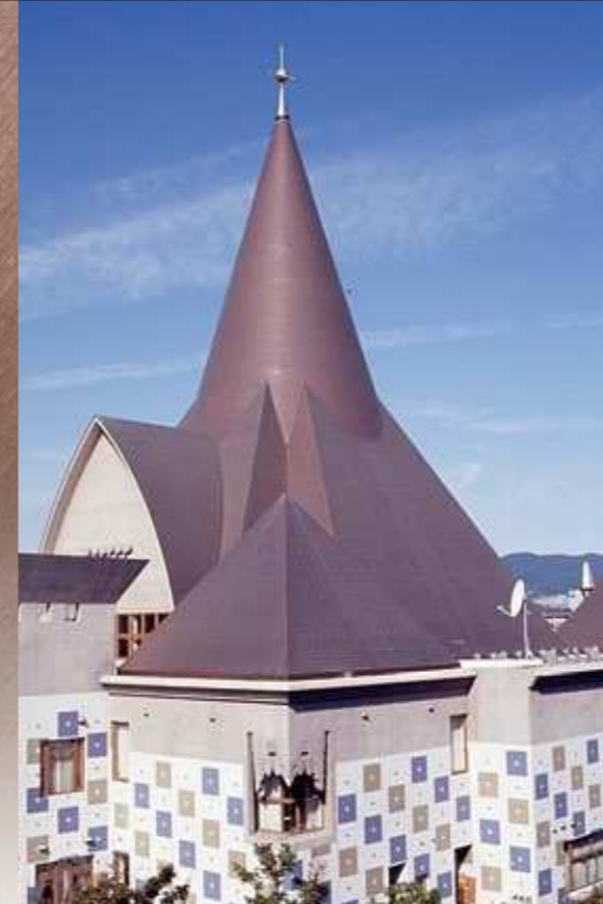
■伊丹サンシティホール(兵庫県伊丹市) 材質:銅板 ●設計/(株)坂倉建築研究所 ●施工/(株)柄谷工務店
