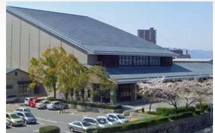
■県立草津文化芸術会館(滋賀県草津市) 材質:緑青銅板(現在は生産中止) ●設計/滋賀県建築設計管理事業協同組合 ●施工/(株)笹川組
